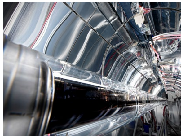
QUARZ-Zentrum des DLR zur Qualitätsüberprüfung von CSP-Komponenten und -Systemen.
