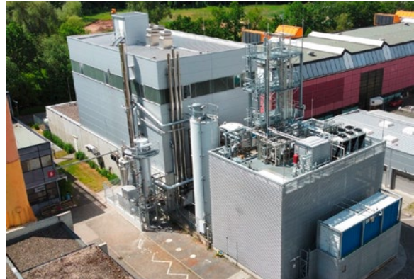
Die 1 MW-Modulare-Pilotanlage der TU Darmstadt zum Erproben thermischer Wirbelschichtverfahren.
